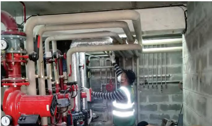
En mars, une action d'isolation des tuyaux, des canalisations d'eau, de chauffage et des chaudières a été entreprise dans tous les bâtiments communaux, soit sur 1 km de canalisation.
