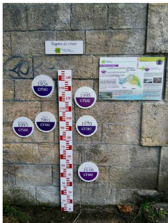
Exemple de repères de crues et panneau pédagogique, installés par l'EPTB Entente Oise à Persan (95).
