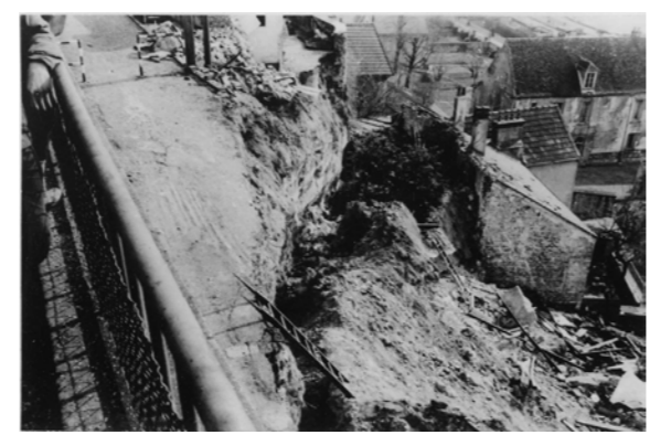
Conflans, glissement terrain
