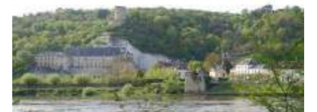
Le site de la Roche-Guyon (Val d'Oise)
