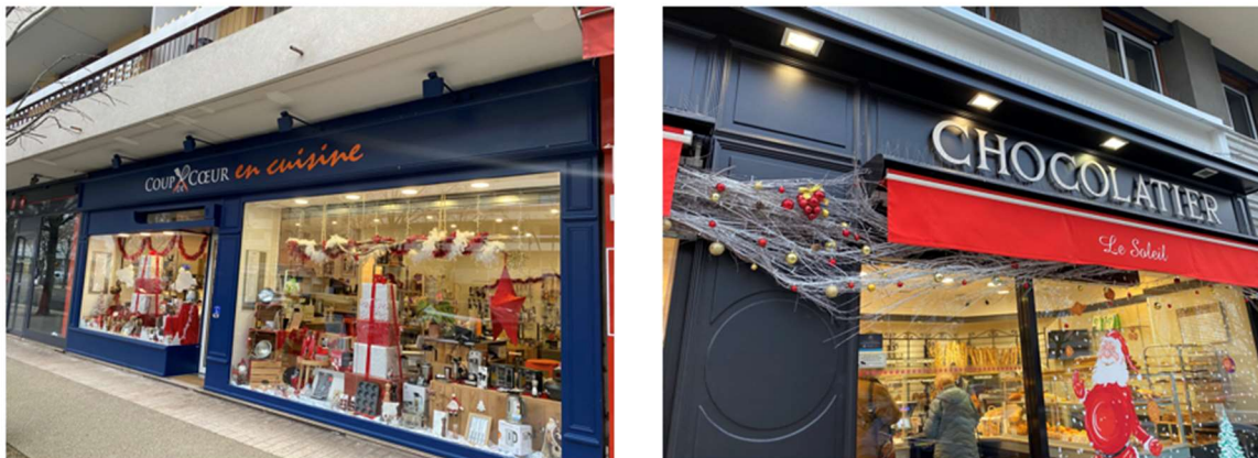
Exemples de modes de réalisation de l'enseigne parallèle admis en lieux protégés, en ZP1 et en ZP2b : lettres peintes sur devanture en bois, lettres découpées, écritures sur lambrequin de store.
